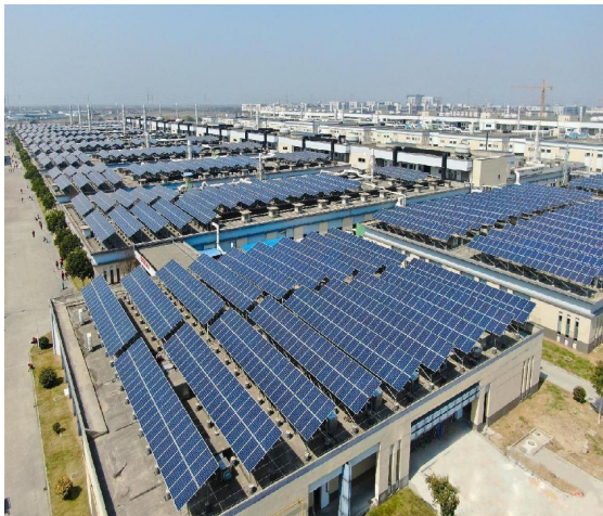
泰州园区光伏发电项目
