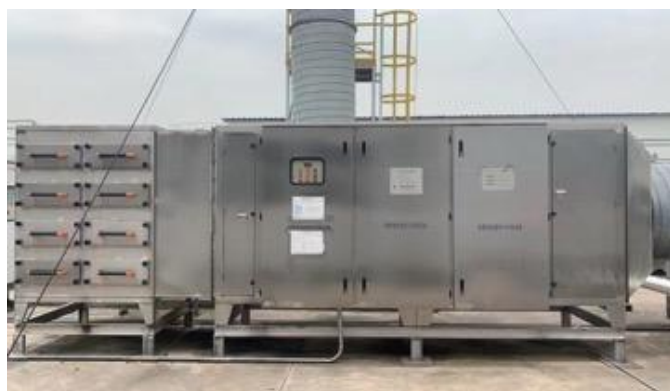
废气设施改造加装碳箱
